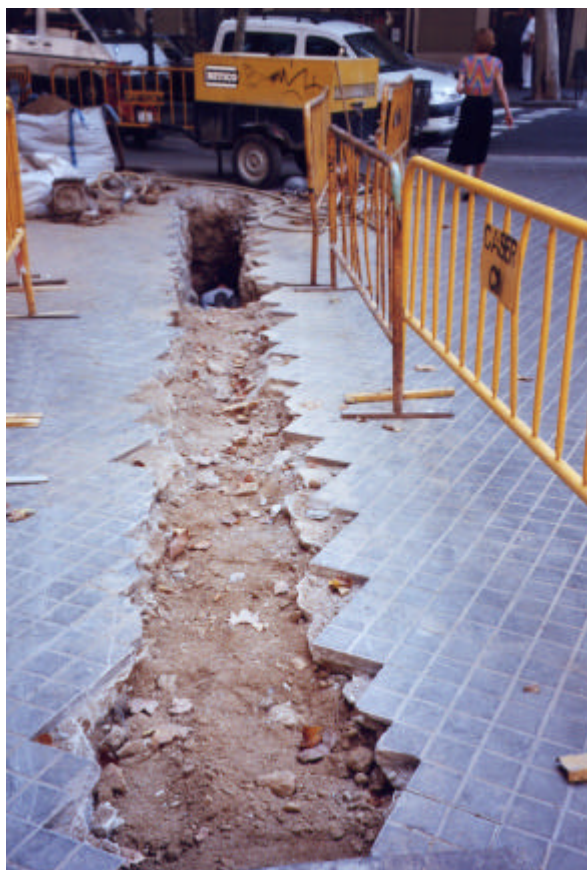
Foto 2. Vista general del tram final de la rasa.
