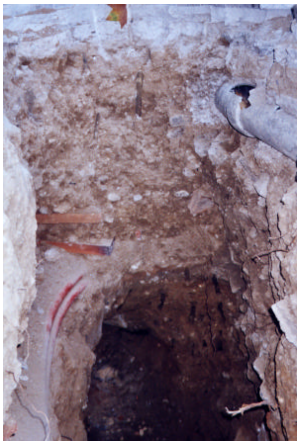
Foto 4. Detall del tram final de la rasa. En la fotografia es pot observar la quantitat de serveis localitzats al subsòl.
