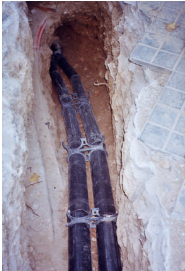
Foto 5. Detall del tram final de la rasa un cop col·locats els tubulars.
